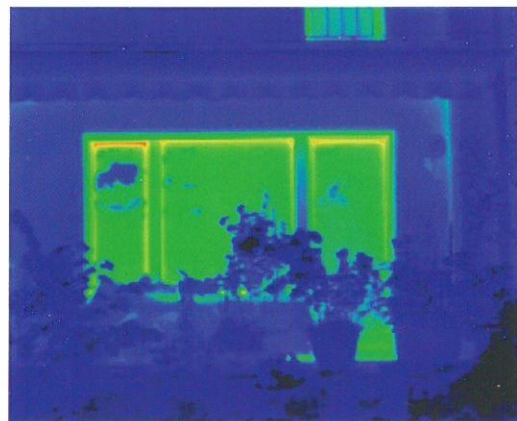
In seguito all'installazione eseguita a regola d'arte di una nuova finestra realizzata con il sistema di profili Schüco Corona CT 70 AS Rondo, l'immagine termografica dimostra l'elevato rendimento energetico dell'investimento. La dispersione di energia iniziale viene quasi completamente annullata.
