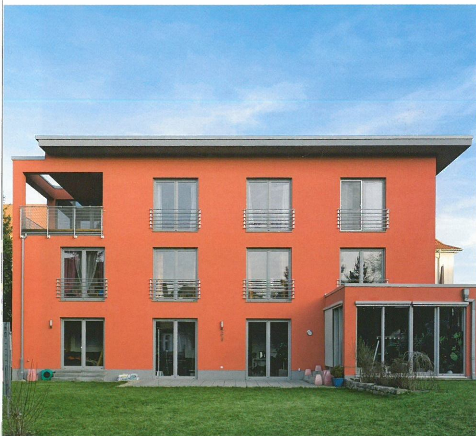
Abitazione plurifamiliare, Erfurt, Germania Apartment block, Erfurt, Germany
